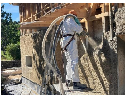
Slika 3 - Brizganje konopljinega betona (vir: Cogreen d.o.o., logotip projekta Gorički ole. oljna klet (vir: Inštitut ICANNA)
